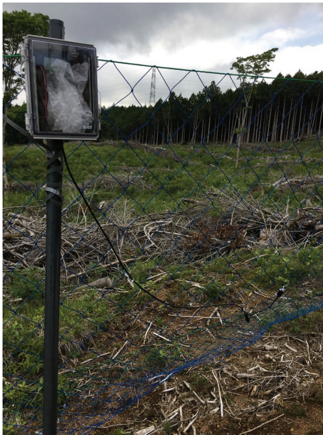
図4-1 加速度センサーとロガー装置の設置状況
