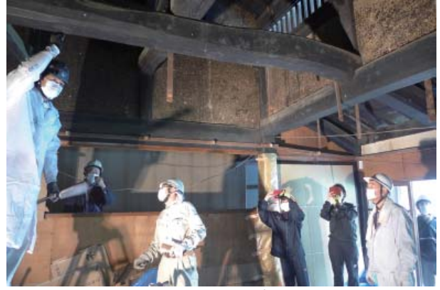
図 21 天井はがしワークショップ 作業中の様子。記録補助をする学生
