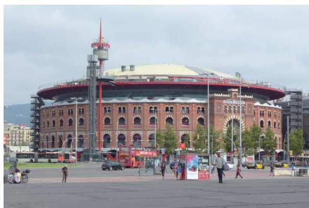
図 32 ラス・アレナス (バルセロナ) 闘牛場の外壁を残し商業施設に転化した
