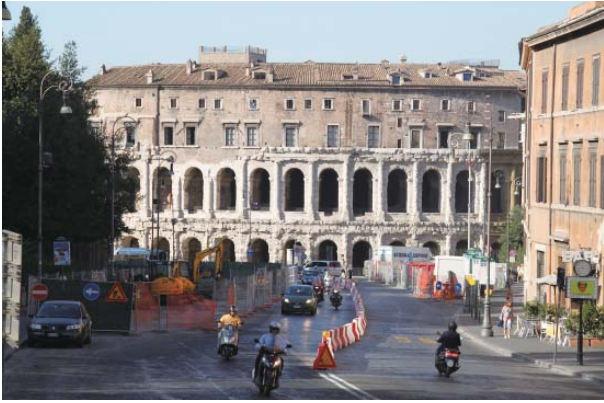
図9 マルケルス劇場（ローマ） 古代の劇場を基礎として上部に住宅が増築された
