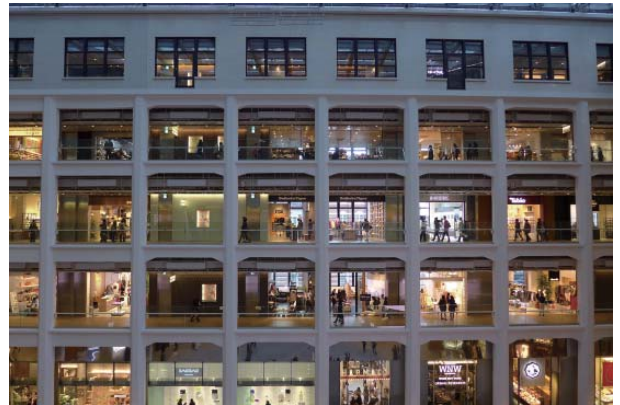
図 47 東京中央郵便局 かつての背面が商業施設の吹抜に面する
