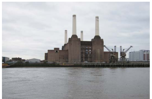
図24 バタースー発電所（ロンドン） 旧発電所の再生を中心に大規模開発が進行中
