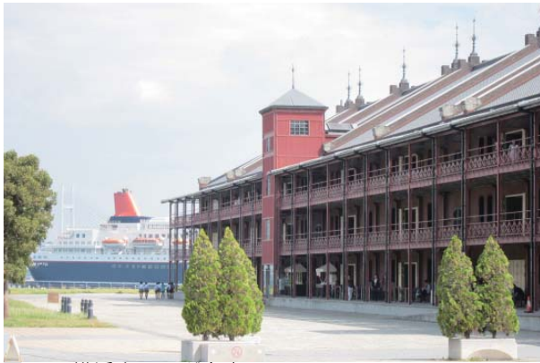
図 42 横浜赤レンガ倉庫 海に近い港湾倉庫の特徴がユニークな景観を生む
