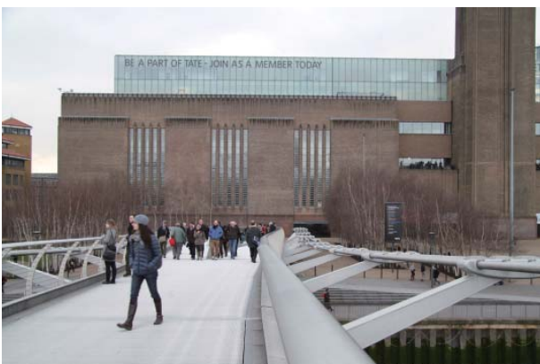
図20 テート・モダンに北岸のシティからアプローチ できるミレニアム・ブリッジ
