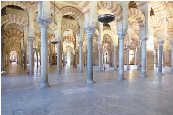
図18 メスキータ（コルドバ） スポリアによって調達された初期部分の円柱群
