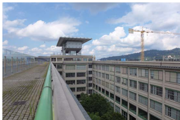
図 30 フィアット・リンゴット 屋上には旧テストコースがあり会議場が付加された
