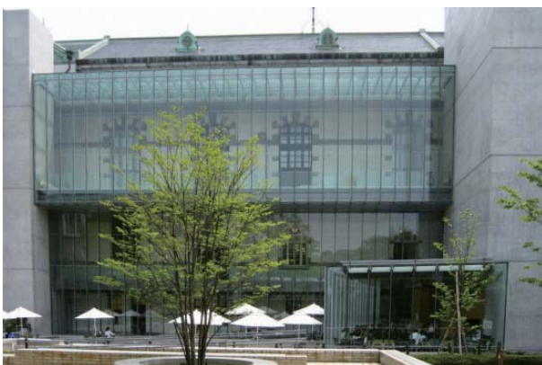
図 44 国際こども図書館 旧外壁の外側にガラスの通路を付加
