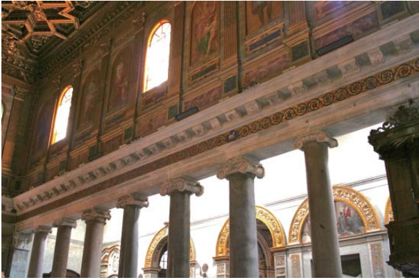
図17 サンタ・マリア・イン・トラステヴェレ（ローマ） 古代ローマの石材を再利用した不揃いな柱と柱頭
