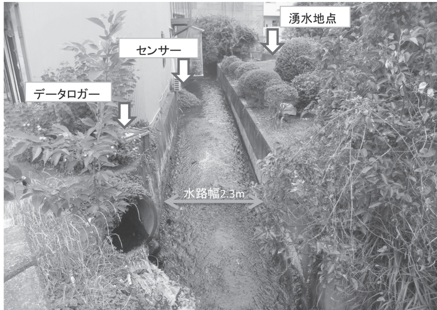
写真-1 湧水測定地点（法雲寺東側）
