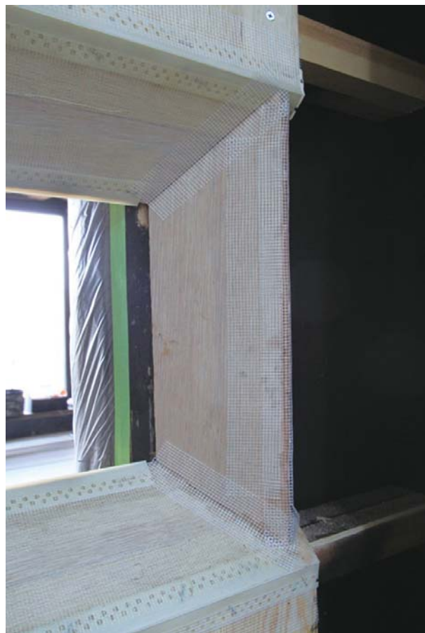
スリットの外壁側はテーパーを切る
