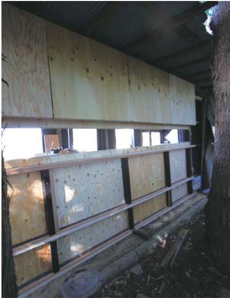
壁の構造体を設置
