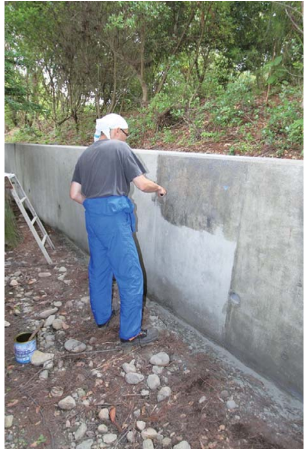
シーラー塗布作業
