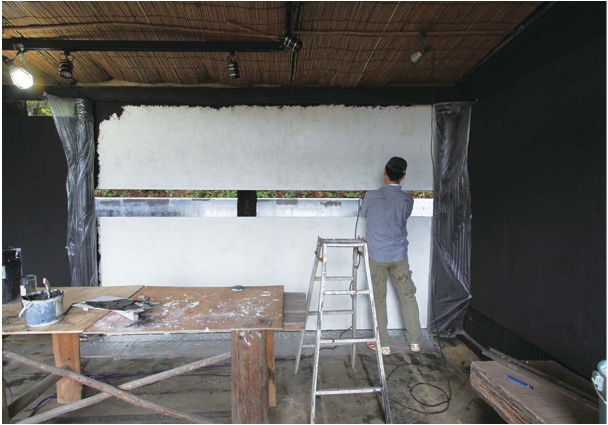
スリットは絶対水平を確保するため、水平器を多用し、慎重にエッジを決定していく
