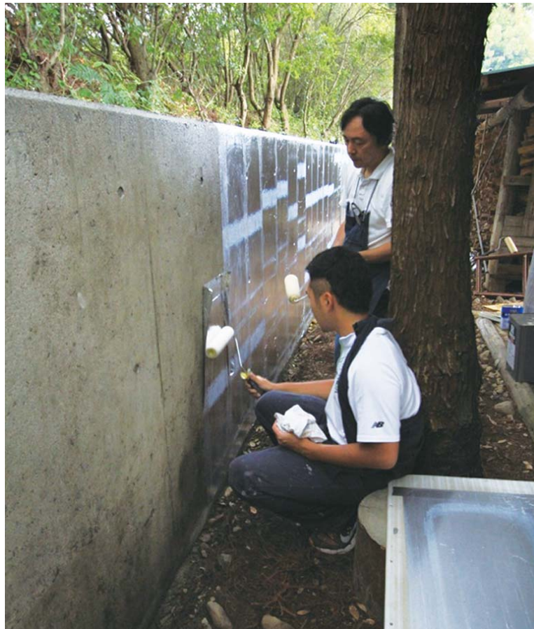
箔の貼り込み作業
