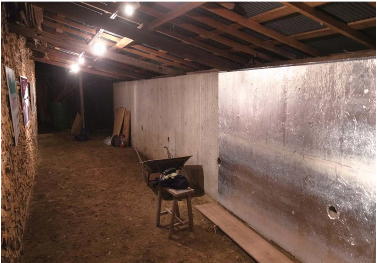
薪を移動させた後に露出した壁に箔を貼り込む
