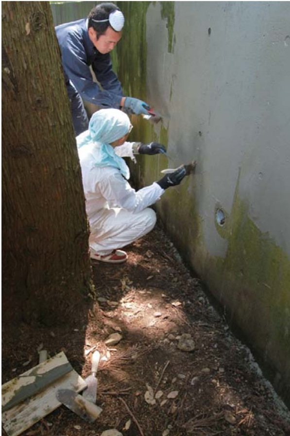
モルタル塗布作業
