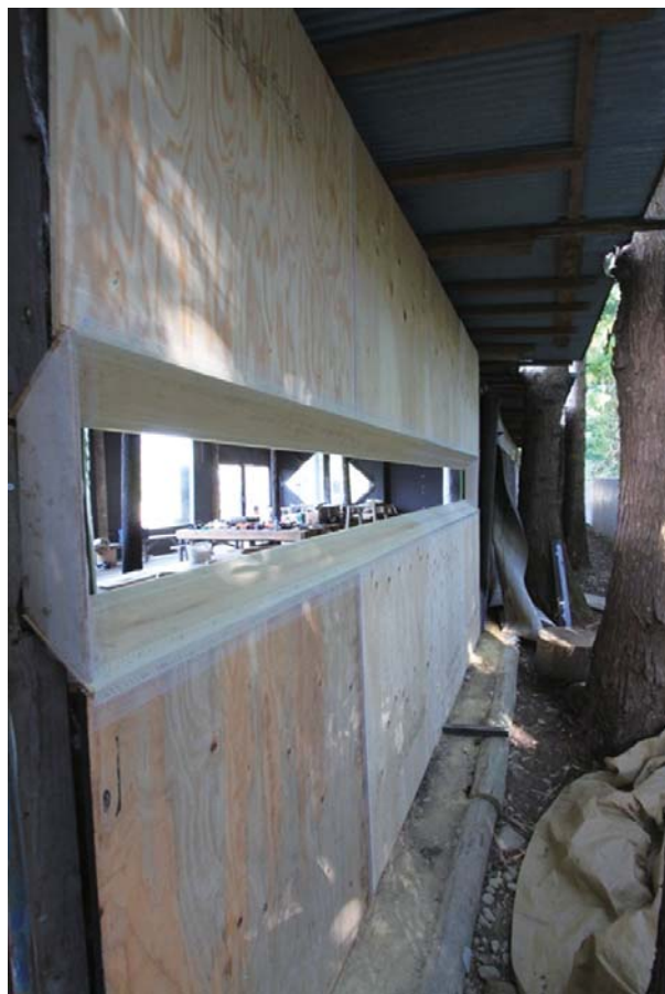
外壁側から見たスリット部分
