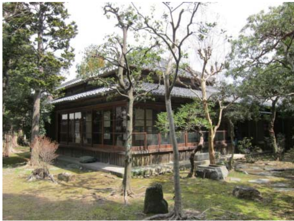
座敷 南西面を庭から見る
