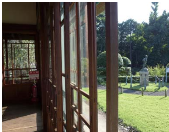
図 4-23 秩父宮御別邸 御別邸時代に付加された2重建具、西側
