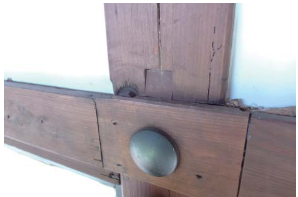
図 4-11 井上別邸 座敷西側縁、長押裏に打たれたボルト
