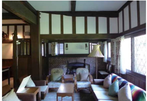
図 4-9 井上別邸 洋間のレンガの暖炉、ハーフティンバー
