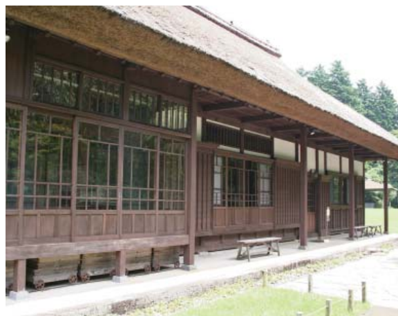
図 4-22 秩父宮御別邸 御別邸時代に付加された2重建具、南側
